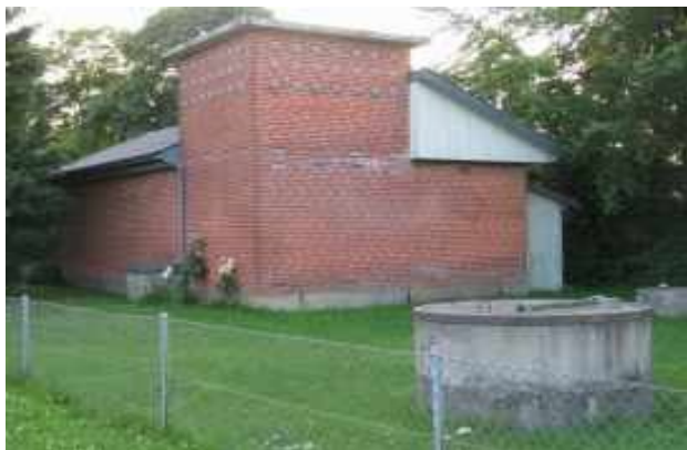
Foto: Vandværket, Lønbjergvej 4
